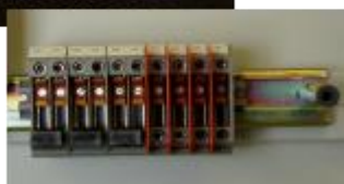
Abbildung 2: Anschlussklemme im Zählerwechselschrank
