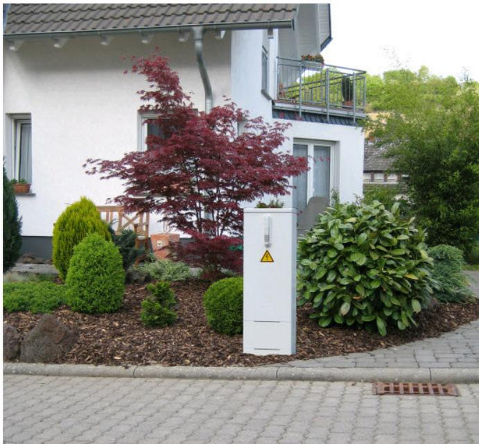
**Bild 8:** Beispiel für eine Haus-/Zähleranschlusssäule (Quelle: Energienetze Mittelrhein GmbH & Co. KG)
