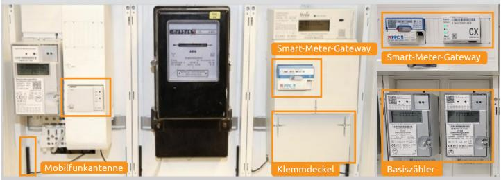
Intelligentes Messsystem eHZ-Zähler + Smart-Meter-Gateway Konventionelle Messeinrichtung Ferraris-Zähler Intelligentes Messsystem Drei-Punkte-Zähler + Smart-Meter-Gateway Intelligente Messsysteme Gateways im Raum für Zusatzanwendungen
