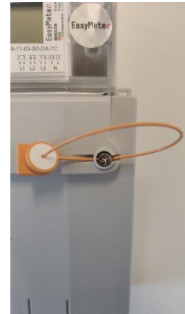
Abb. 4 Kunststoffdraht einfädeln
