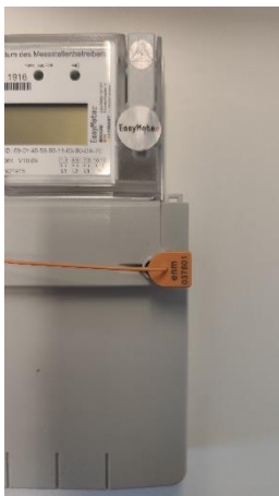
Abb. 5 Kunststoffdraht durchziehen
