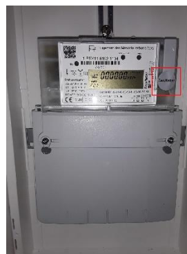
Abb. 10 Klebesiegel an einer modernen Messeinrichtung
